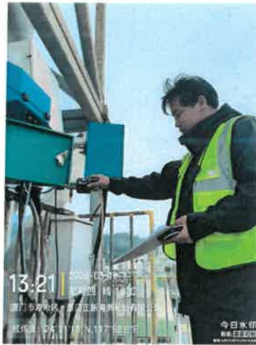
101 车间总排口 (DA001)
