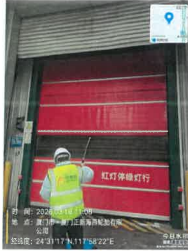
205 车间西南侧门外 1 米
