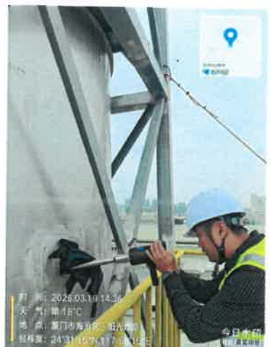
302 延压押出车间总排口 (DA018)
