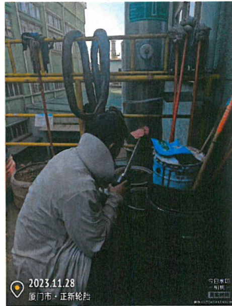
502 修检车间排气筒出口 (DA049/49 号排气筒)
