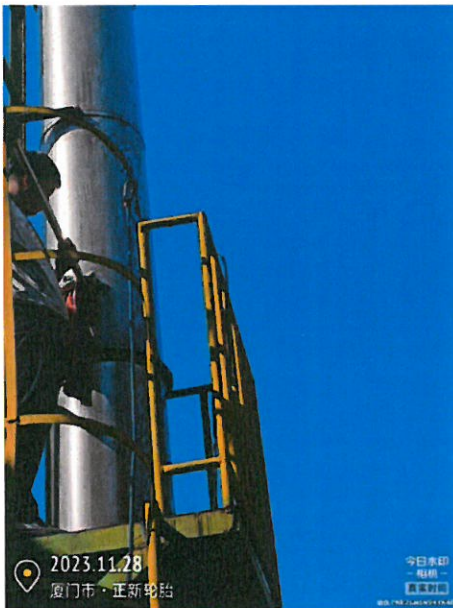
306 成型车间排气筒出口 (DA041/41 号排气筒)
