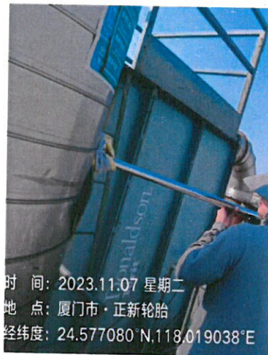
302 成型车间排气筒出口 (DA037/37 号排气筒)
