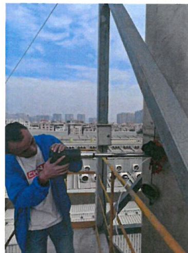
303 车间硫化车间排气筒出口 (DA057/57 号排气筒)
