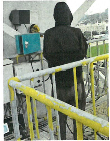
301 混炼车间总排口 (DA002)
