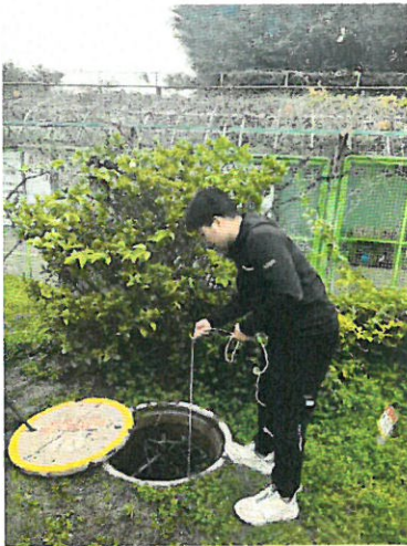
污水站总排口
