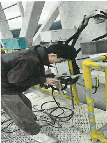
501 混炼车间总排口 (DA003)
